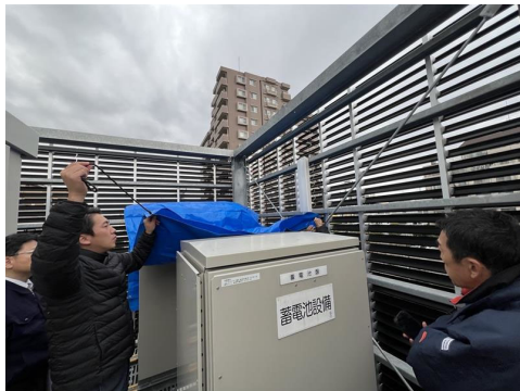
太陽光パワーコンディショナー盤の養生作業
