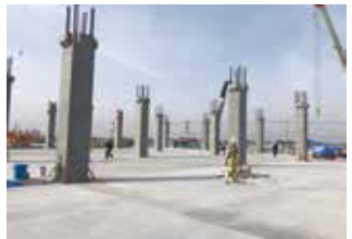
PC柱建方状況
