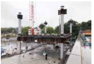
ランプ鉄骨建方状況
