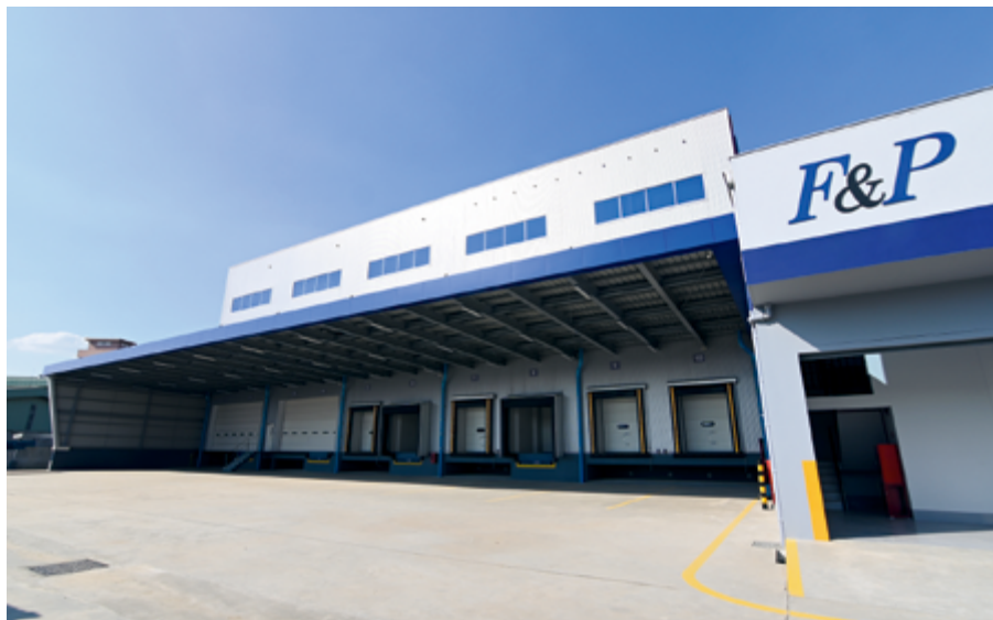
▲抜群のロケーションを誇る「L.L. Town Tharkayta」。ティラワSEZやヤンゴン中心街にアクセスしやすい場所に位置し、最先端設備を揃え、今後も注目度大
