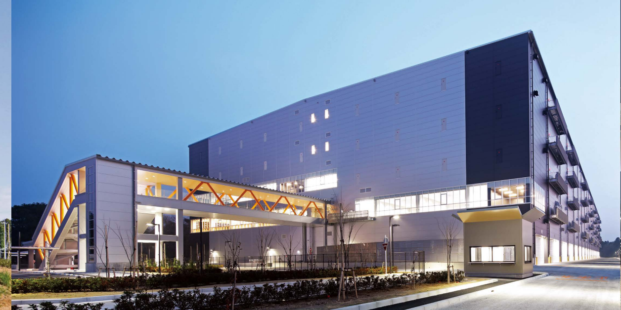
上/南東側鳥瞰 下/北東側夕景
