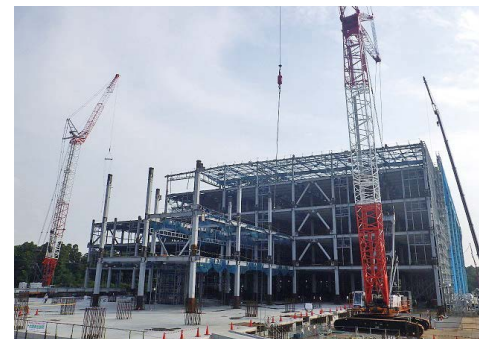
鉄骨建方状況
