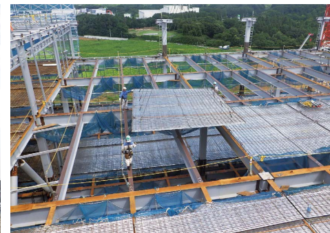
デッキ地組ユニットの敷込状況
