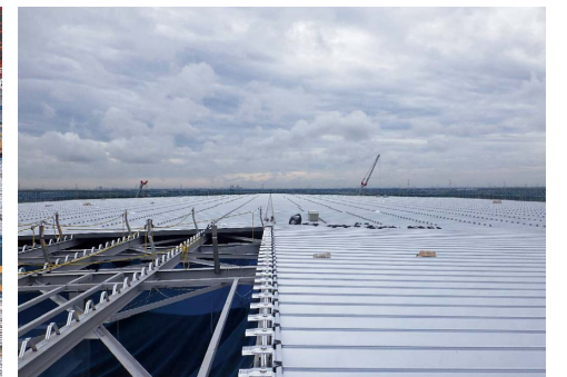
屋根先行葺き状況
