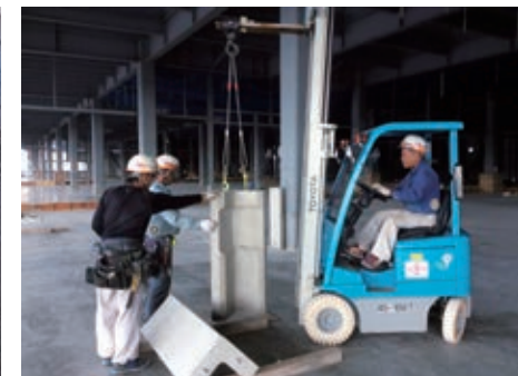
柱ガードPC取付状況
