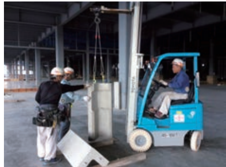
柱ガードPC取付状況
