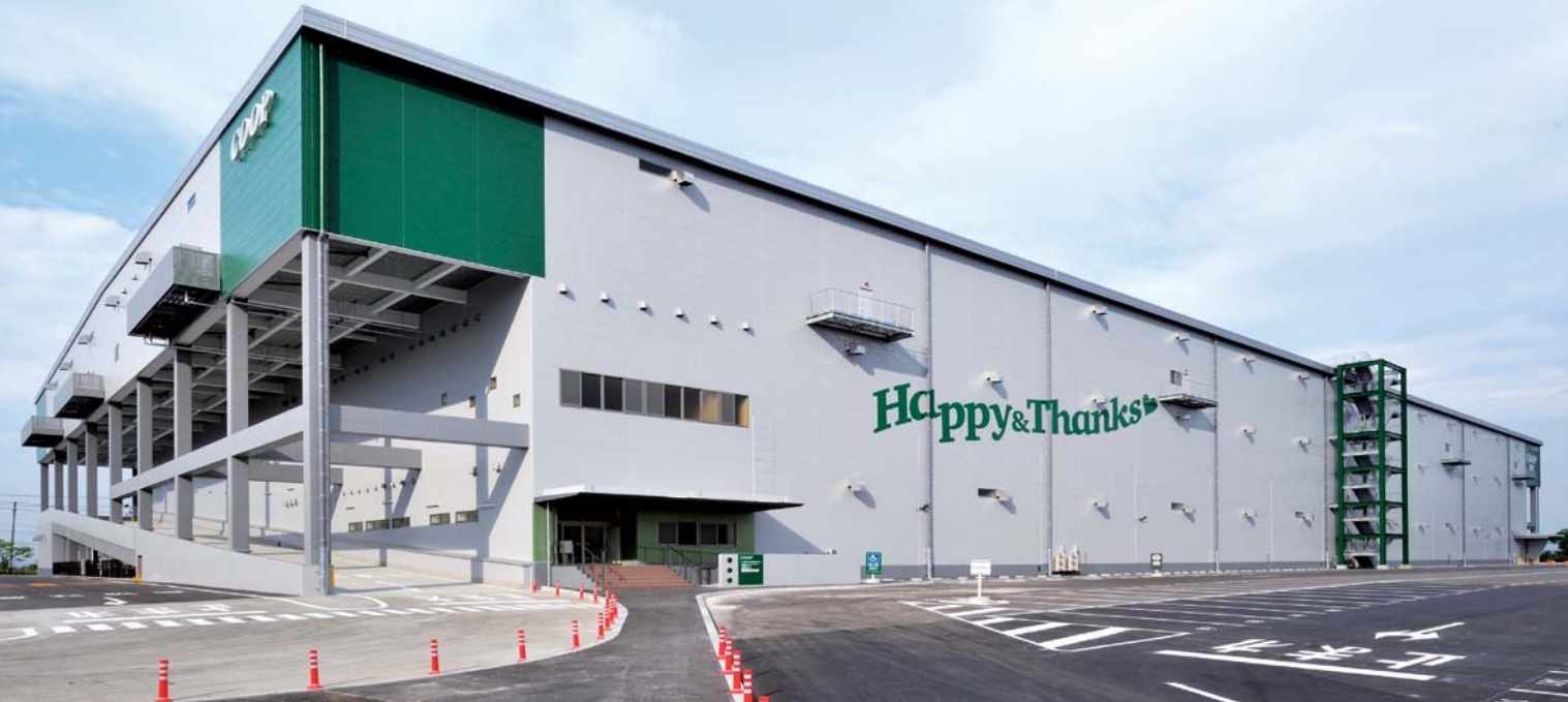
北側外観全景
