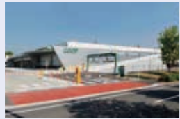
数多くの最新鋭設備を導入したコープ 富谷共同購入物流センターの航空写真 (上)と全景(下)
